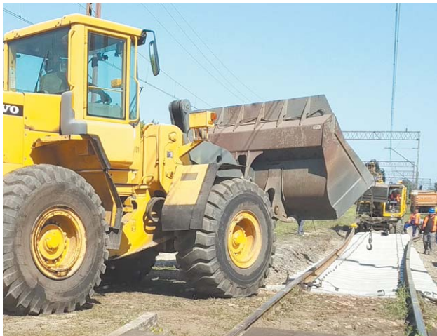
Prace modernizacyjne potrwają do 12 września
