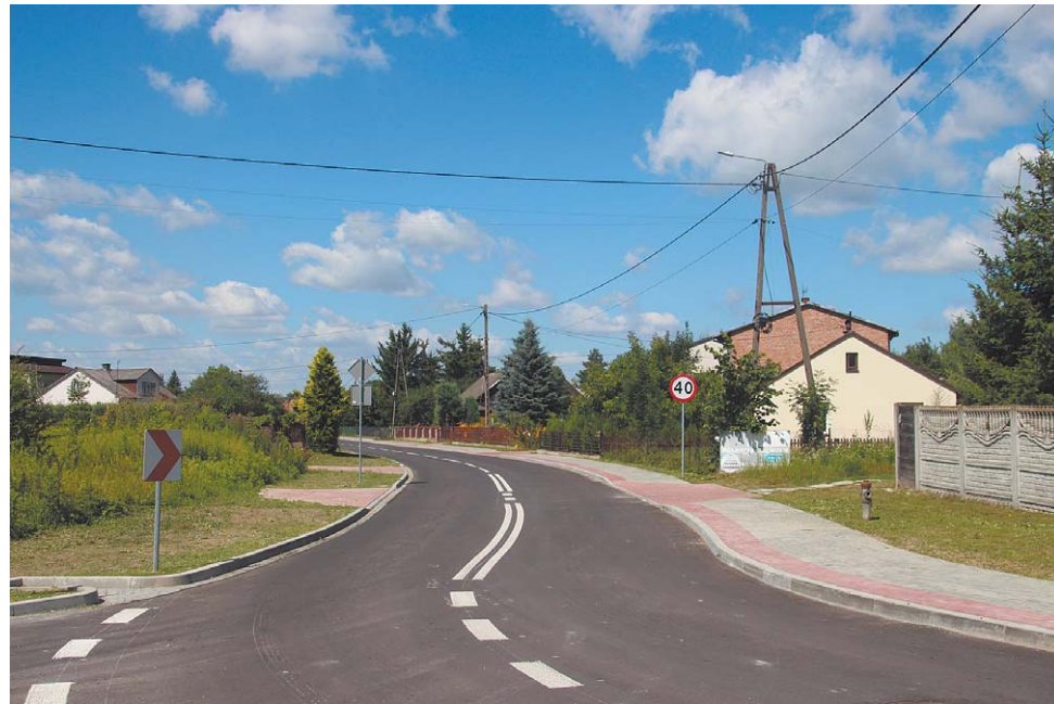
Przebudowa ulicy Budzyńskiej w Kraśniku została zakończona w czerwcu
