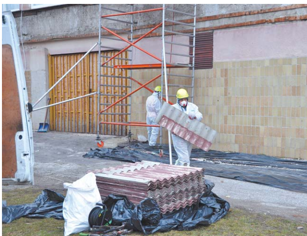
Z elewacji usunięto już niebezpieczne dla zdrowia panele z azbestu. Zrobiono to podczas ferii, kiedy uczniów nie było w szkole
