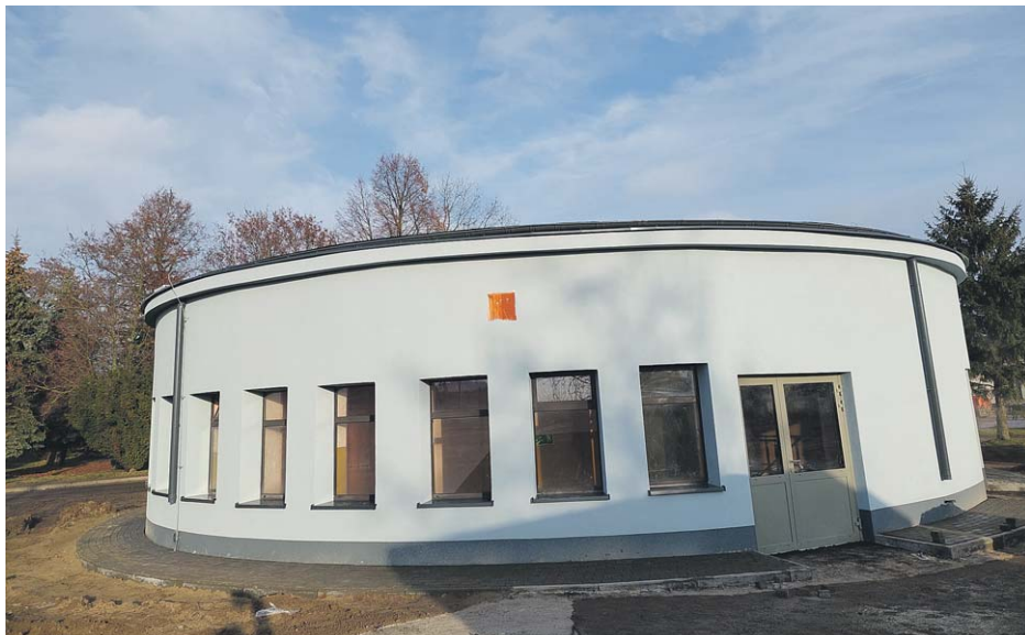
Fot.1 Widok na elewację dotychczasowej przepompowni ścieków na terenie oczyszczalni ścieków w Łukowie
