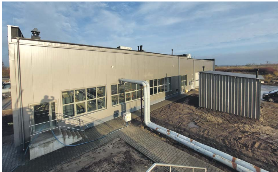
Fot.2 Widok na budynek krat i przepompownię główną na terenie oczyszczalni ścieków w Łukowie
