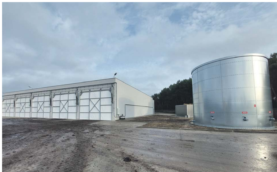
Fot. 4 Widok na bioreaktory i zbiornik p.pož. na kompostowni osadów ściekowych
