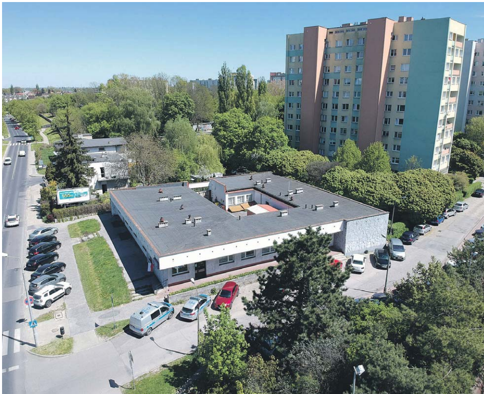
Nowa siedziba komisariatu może powstać w miejscu obecnej, która jest za mała i niefunkcjonalna
