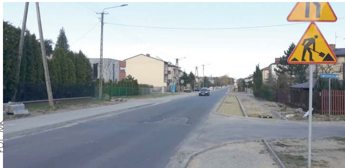
Zgodnie z umową wykonawca przebudowy, którym jest Przedsiębiorstwo Robót Drogowych Lubartów S. A., powinien zakończyć wszystkie prace do 24 lipca
