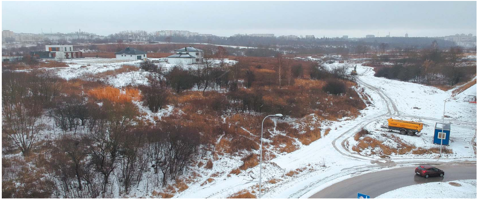
Kolejny wykop na górkach związany jest z kanalizacją sanitarną
