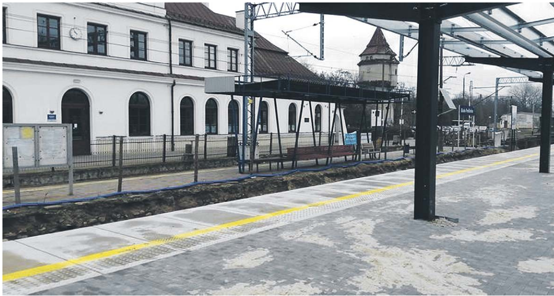
Stacja PKP przy dworcu. Prace mają zakończyć się w pierwszej połowie tego roku
