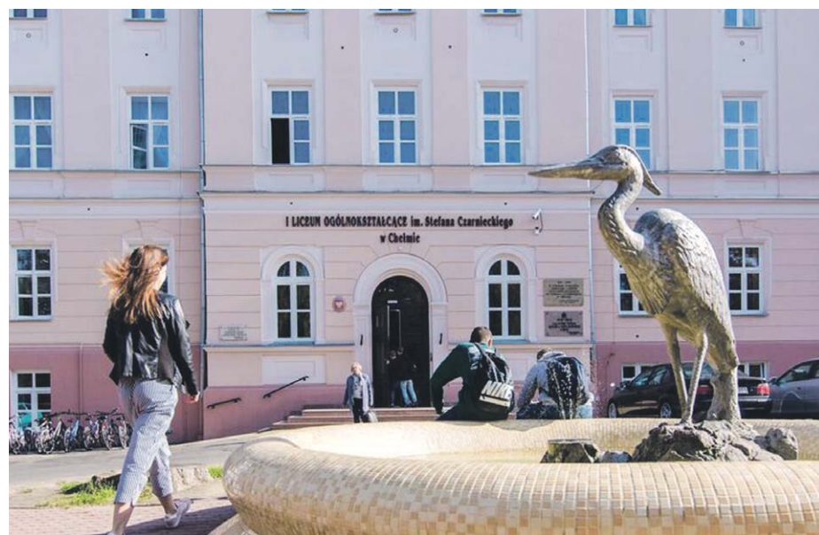
Jedną z chełmskich szkół, która przejdzie termomodernizację jest I Liceum Ogólnokształcące im. Stefana Czarnieckiego w Chełmie
