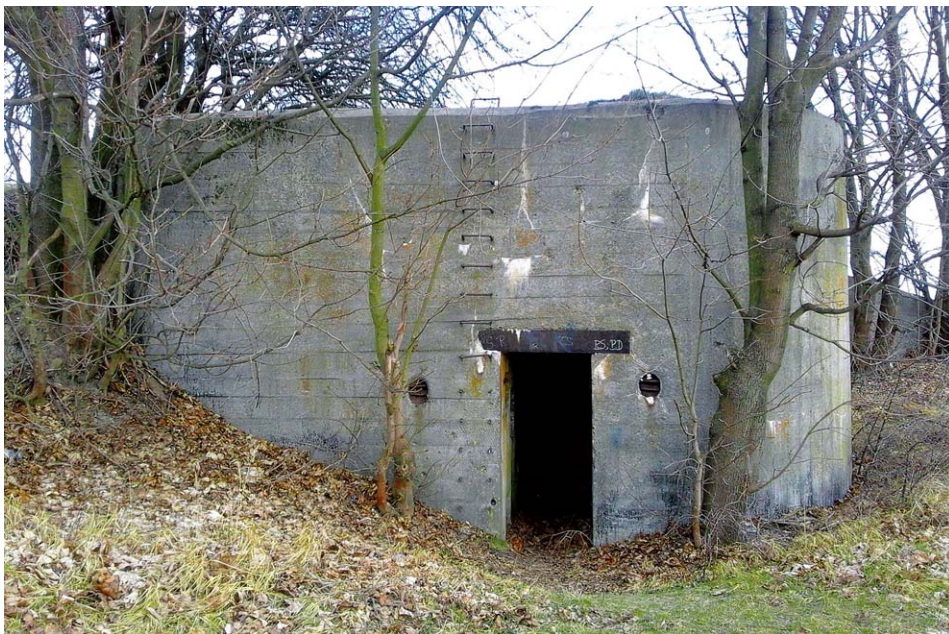
Schron bojowy karabinu maszynowego w Gościeradowie był budowany został wybudowany w 1941 r.
