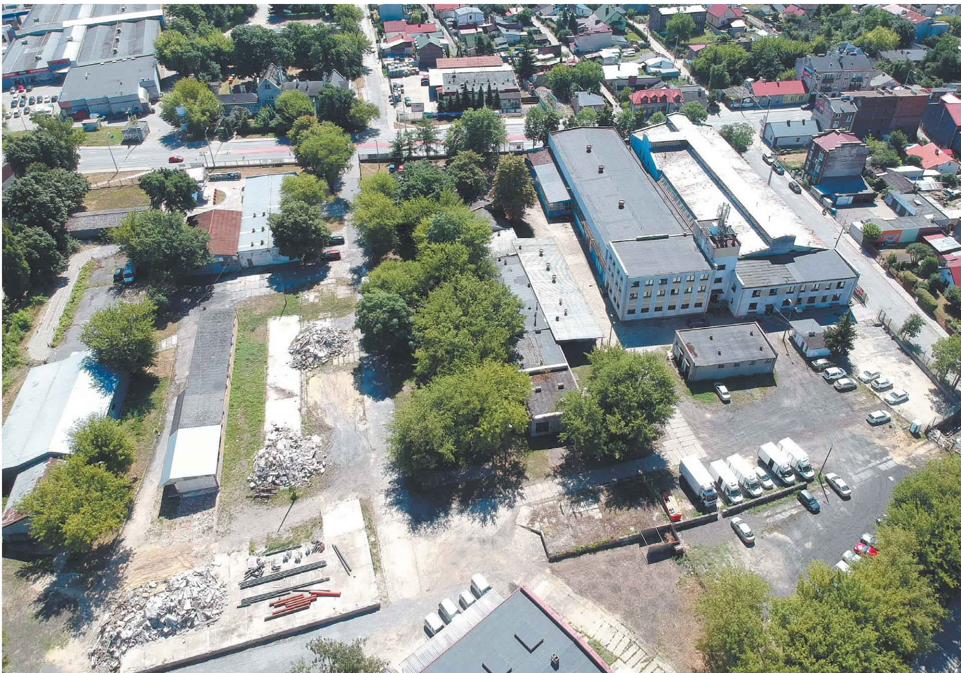
FAWAG nie tylko rezygnuje z budowy nowej fabryki na Felinie. Spółka postanowiła też rozebrać część zakładu istniejącego od lat przy Łęczyńskiej 58
