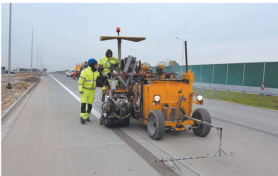
Fragment S17 Garwolin-Kołbiel ma nieco ponad 13 km i trwają tam już ostatnie prace wykończeniowe FOT. GDDKiA
