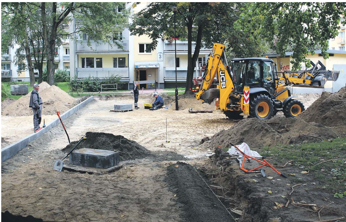
Mieszkańcy wieżowca na Lessla 1 muszą przyzwyczaić się do tymczasowych utrudnień. Przed ich blokiem pracuje ciężki sprzęt. Roboty mają zakończyć się w październiku
