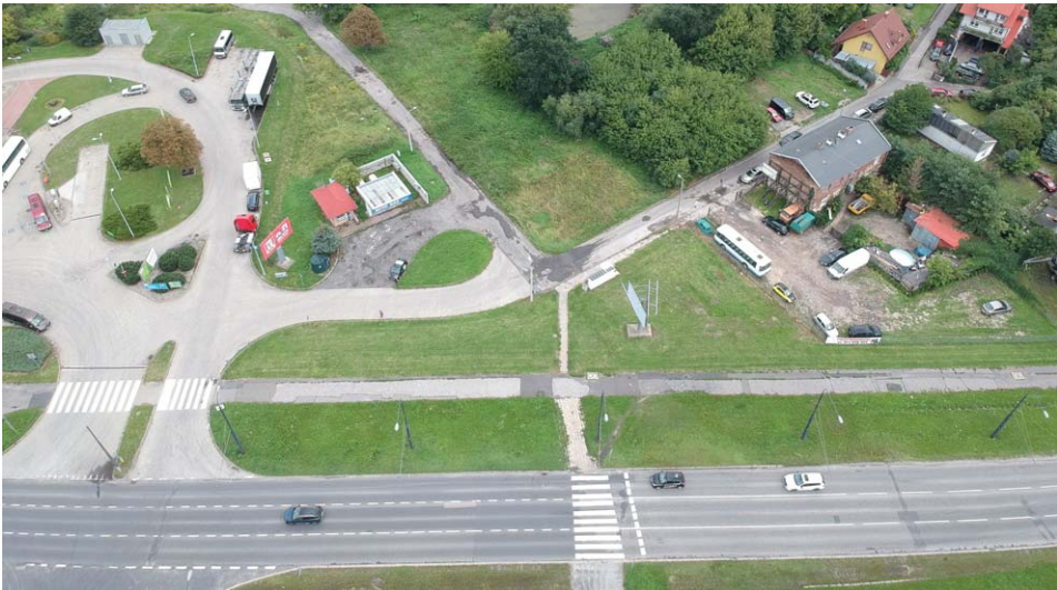
Ul. Przemysłowa nie ogranicza się do ślepego odcinka z wjazdem od ul. Zamojskiej, bo ma również dalszy ciąg za dwupasmówką
