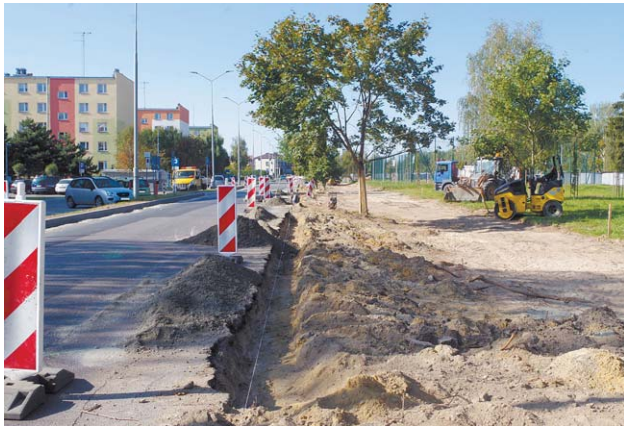
Budowa parkingu przy ul. Batalionów Chłopskich
