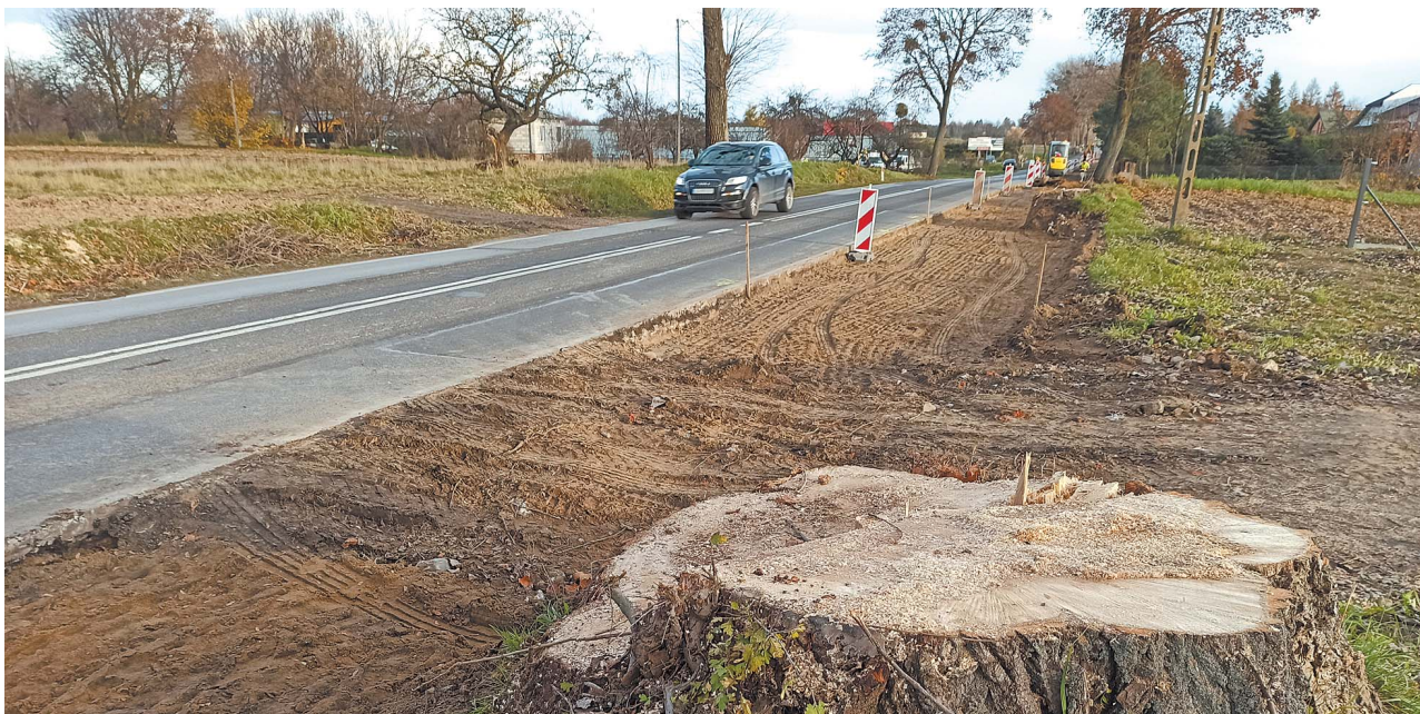
Zarząd Dróg Wojewódzkich nie ukrywa, że podczas remontu drogi na Nałęczów dojdzie do wycinek drzew. Na zdjęciu: wycinka w Sadurkach w 2020 roku przy okazji budowy chodnika
