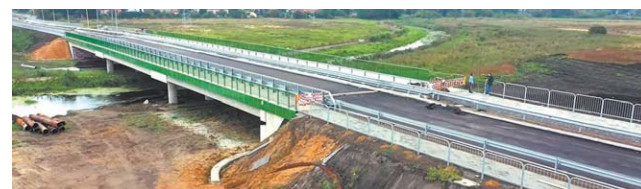
Budowa mostu w Białej Podlaskiej
