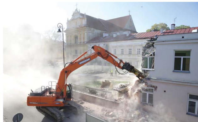
Wyburzenie budynku szpitala przy ul. Staszica. Przez lata przyjmowani tam byli pacjenci, ale właśnie trwa budowa nowych obiektów.
