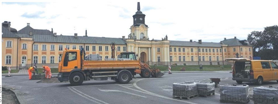
Prace potrwać do końca lipca
