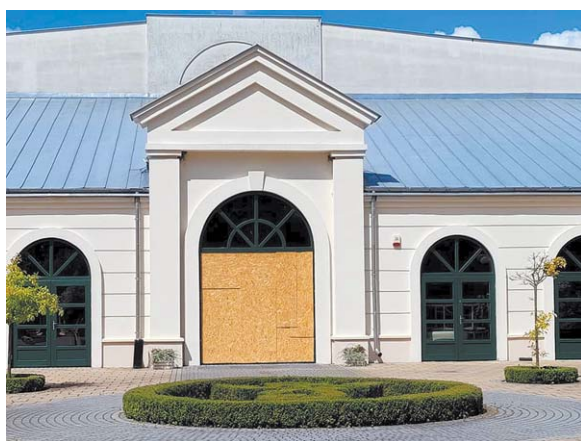
Drzwi zabite płytą na czas remontu i stan obecny
