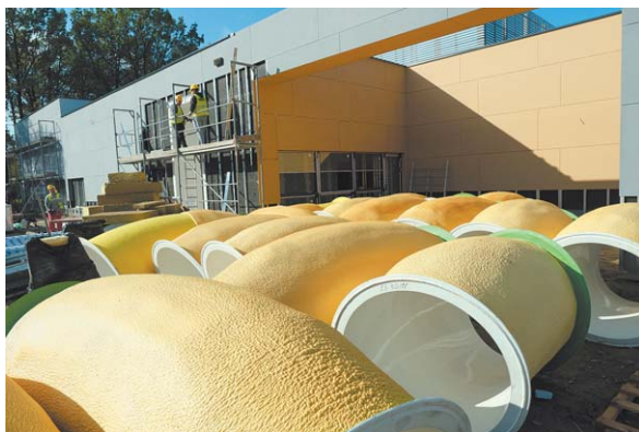
W miejscu dawnych obiektów sportowych Avii powstaje kryta pływalnia, baseny „pod chmurką” i boiska. Wszystko wskazuje na to, że inwestycja zakończy się w planowanym terminie, czyli 17 lutego 2020 roku.
