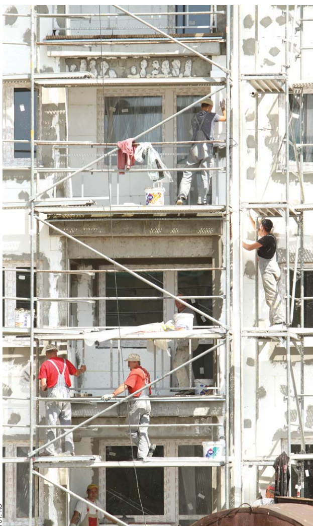
Kapitał na budowę bloków rząd chce pozyskać od sektora prywatnego
