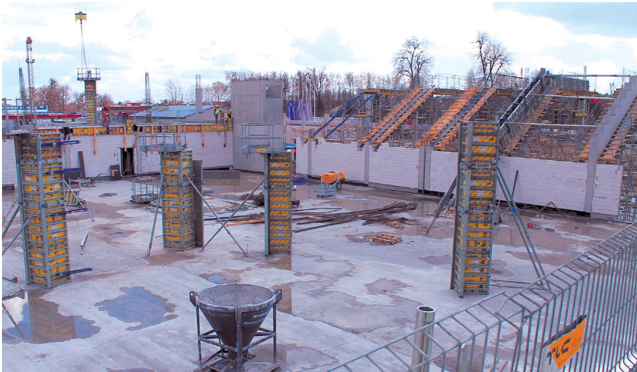
Na budowie widać już zarys przyszłych trybun dla kibiców. W sumie pomieszczą one 3,3 tys. osób
