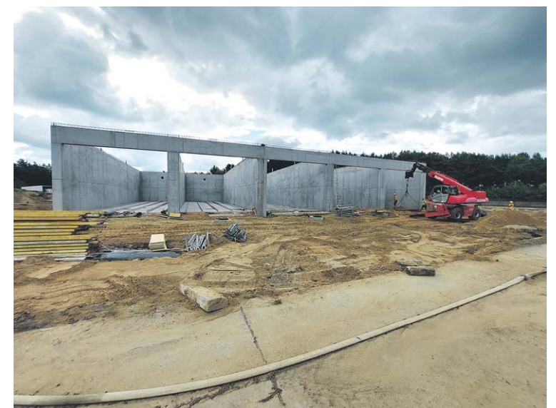
Fot. 3 Roboty żelbetowe bioreaktorów kompostowni osadów ściekowych
