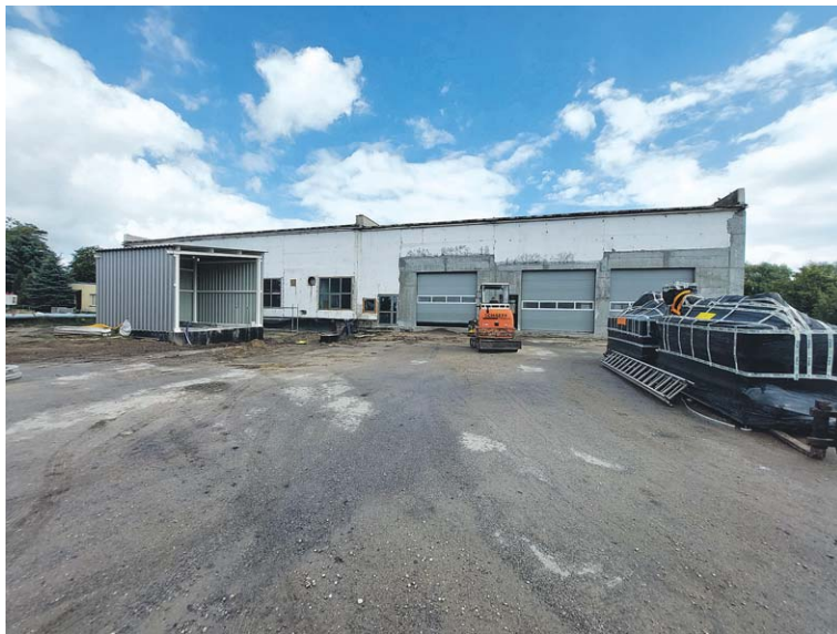
Fot. 1 Pompownia główna oraz budynek odwadniania osadów na terenie oczyszczalni ścieków w Łukowie
