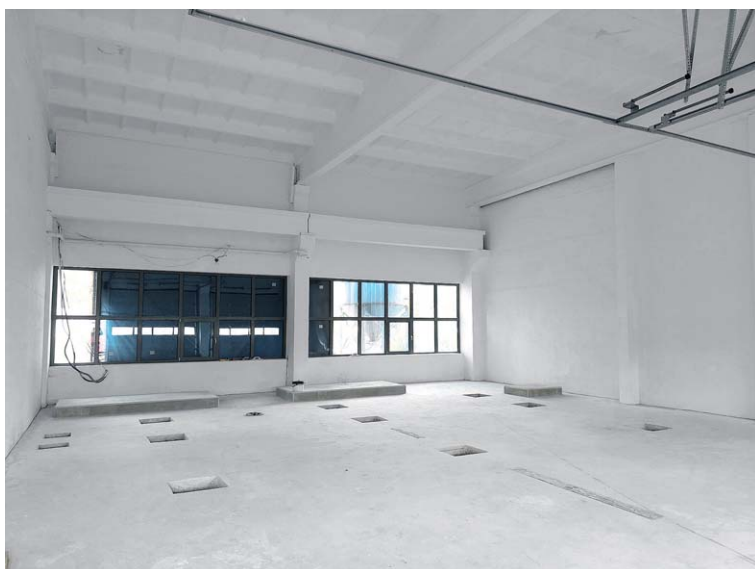
Fot. 2 Pomieszczenie odwadniania osadu na terenie oczyszczalni ścieków w Łukowie
