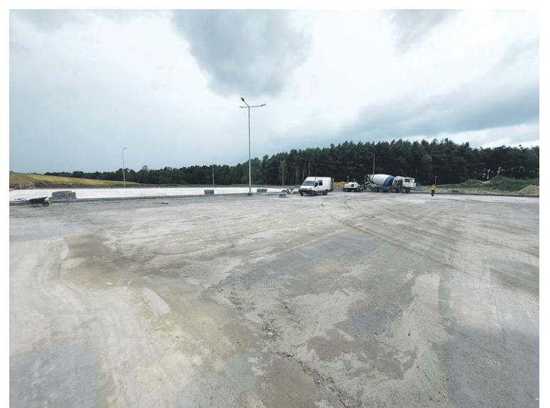
Fot. 4 Roboty betoniarskie placów kompostowni osadów ściekowych
