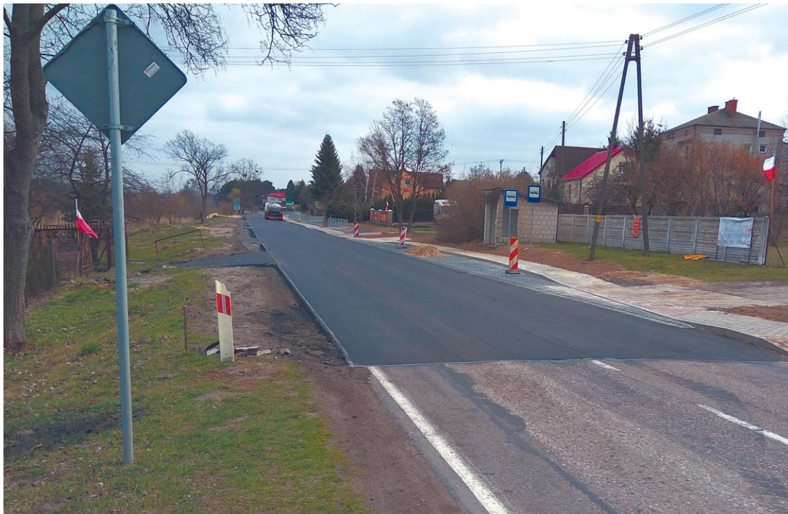
Po protestach mieszkańców władze samorządowe przebudowały 2 km drogi i na tym w 2018 roku remont się zakończył
