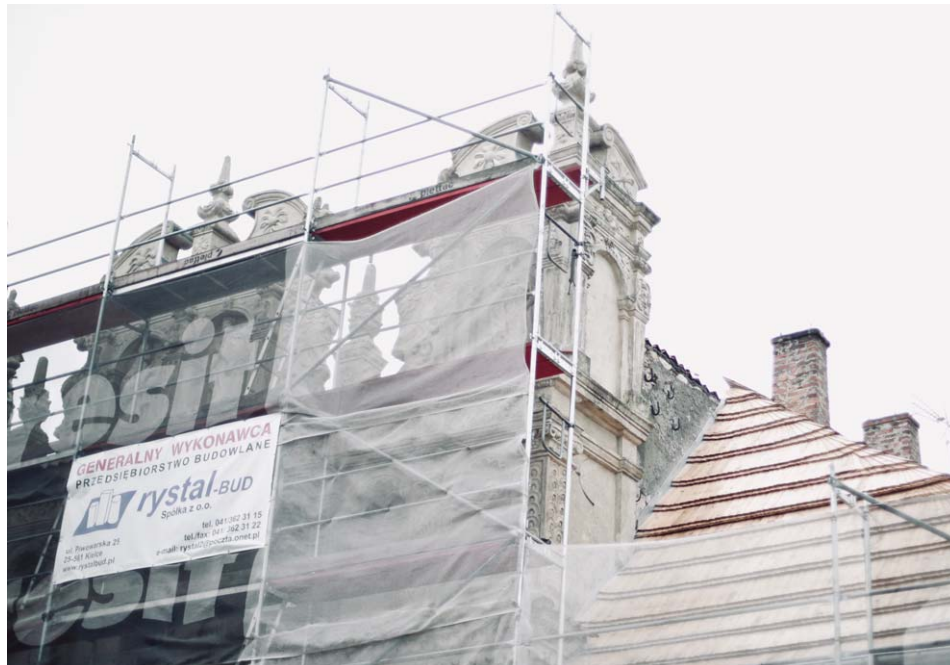
W Kamienicy Celejowskiej trwa m.in. czyszczenie elewacji, wymiana belek stropowych i układanie instalacji
