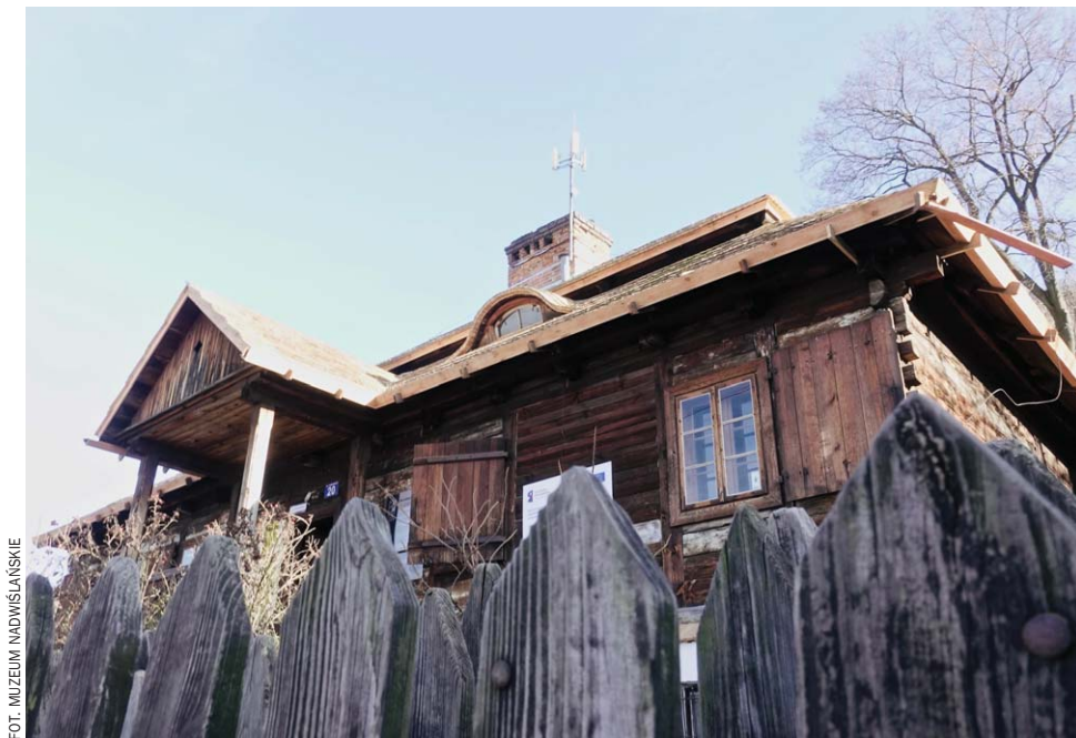
Dwór z Gościeradowa – siedziba Manufaktury Muzealnej zyskał nową konstrukcję dachową wraz z pokryciem z gontu
