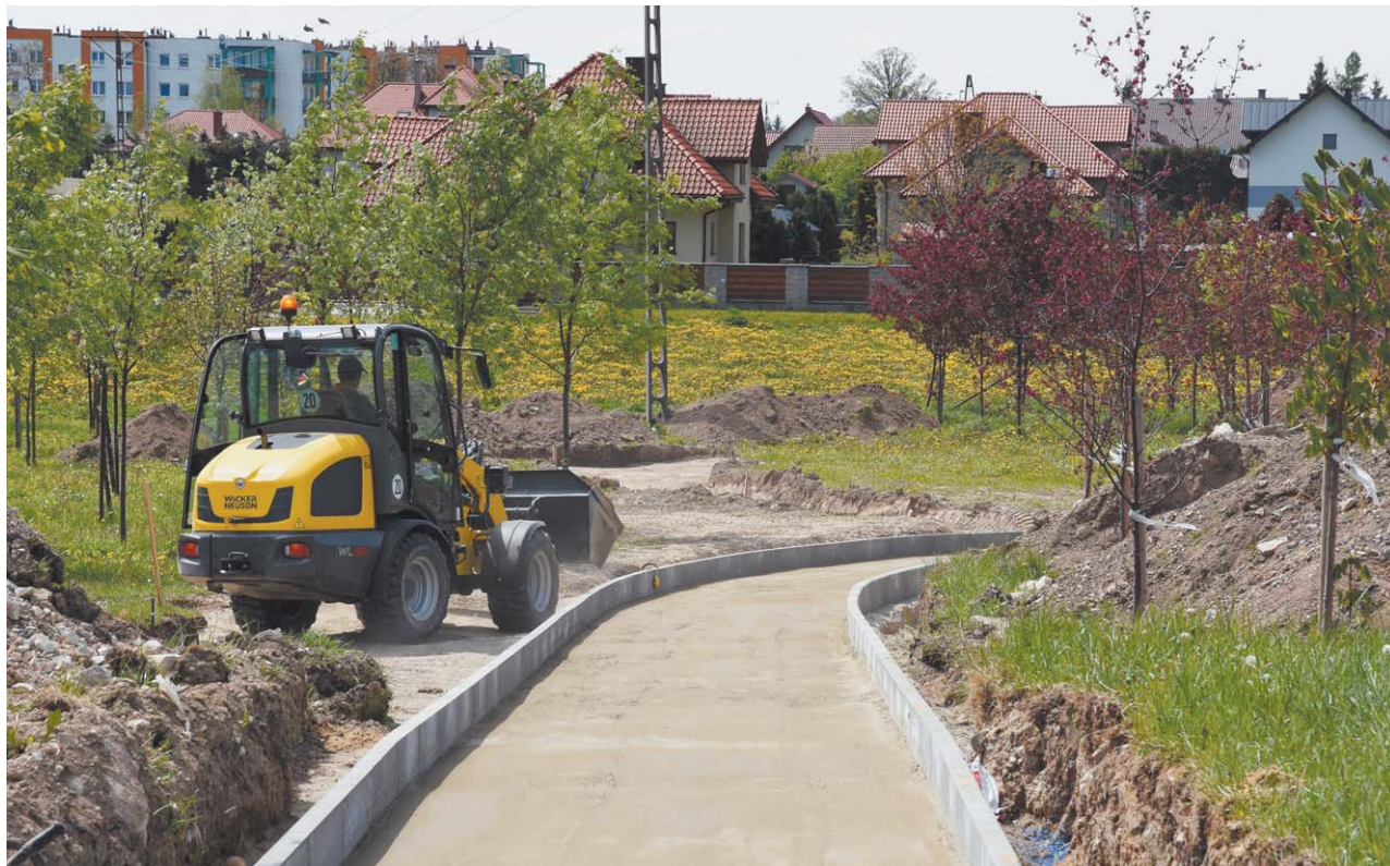
Budowa parku przy al. Lotników Polskich (za stacją paliw) potrwa do końca wakacji.
