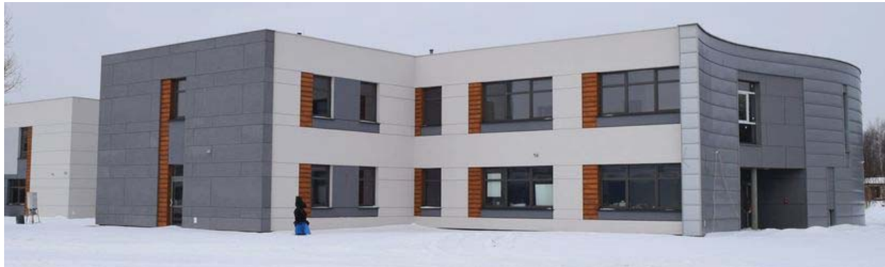
Trwają prace wykończeniowe w nowych obiektach Centrum Pomocy Osobom z Autyzmem
