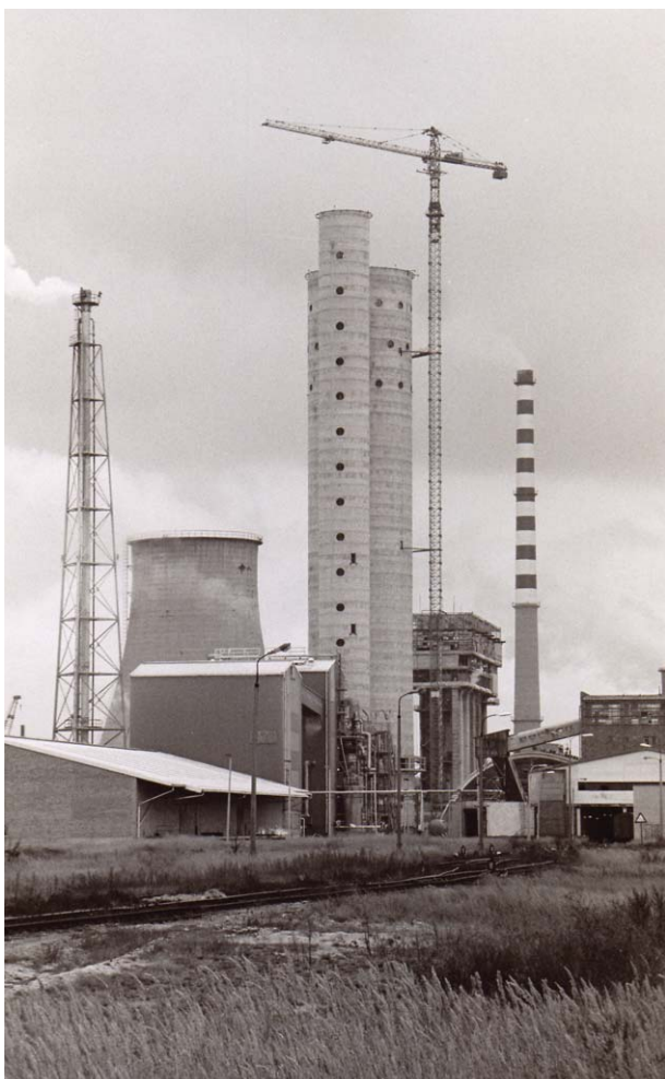
Budowa nowej wieży granulacyjnej mocznika – 1991 rok
