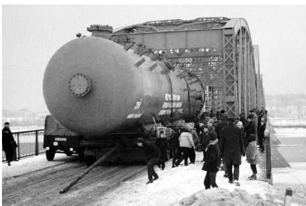
W 1964 roku do Puław dotarł wążący 127 ton regenerator ługu potasowego, stanowiący element wytwórni amoniaku. Przyjechał on na specjalnych platformach z Czechosłowacji. Jego transport odbywał się nocą i trwał prawie 12 dni. Pod względem logistycznym była to jedna z poważniejszych operacji w tamtym czasie.
