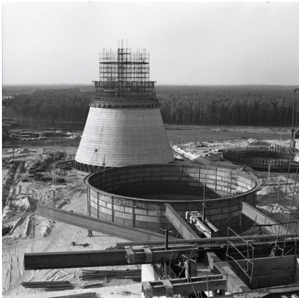
Na początku lat sześćdziesiątych w okolicach Puław był wielki plac budowy. Tu powstaje jeden z najbardziej charakterystycznych obiektów puławskich zakładów, czyli chłodnia kominowa. Na terenie fabryki jest ich 9.
