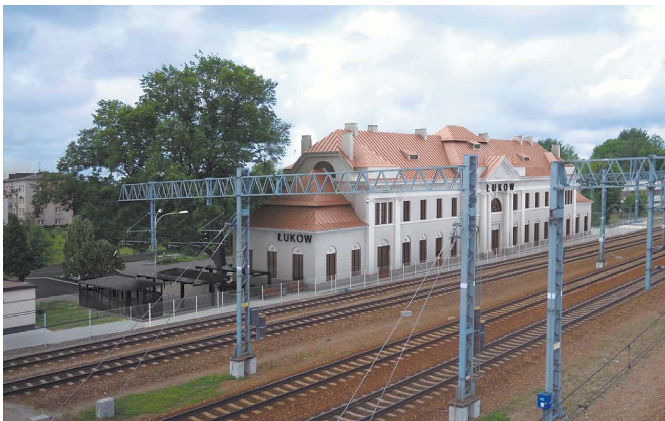
FOT. PKP S.A.
