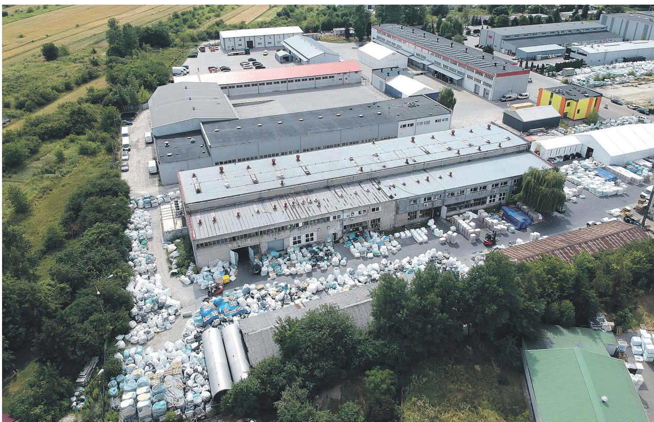
Inwestycja przy Zawieprzyckiej ma pozwolić na pełne wykorzystanie możliwości zainstalowanych już urządzeń
