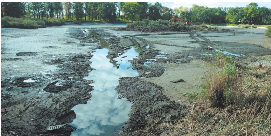
Remont parku rozpoczął się od stawu. Wykonawca czeka na mróz aby wywieźć wyspę
