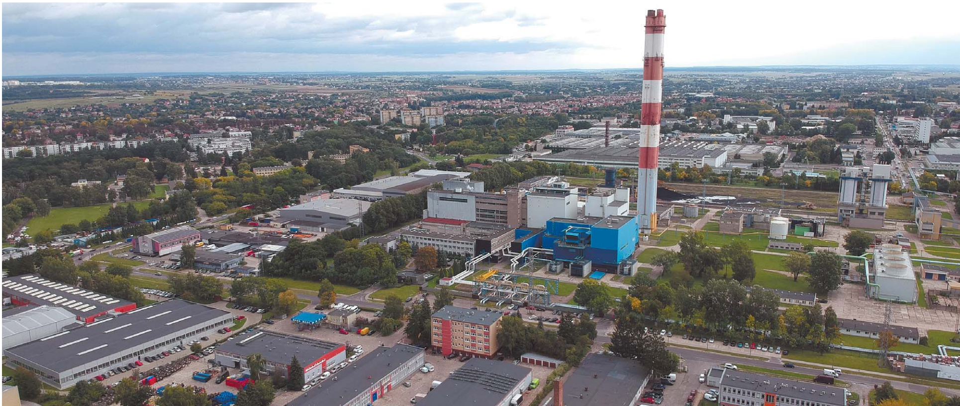
Elektrociepłownia Lublin-Wrotków przy ul. Inżynierskiej, gdzie doszło wczoraj do awarii, pokrywa 60 proc. zapotrzebowania miejskiego systemu ciepłowniczego. Drugim, mniejszym źródłem jest elektrociepłownia Megatem w rejonie ul. Mełgiewskiej
