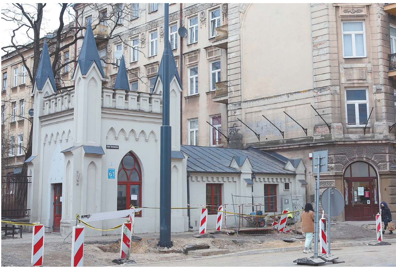
Lokal przy głównym wejściu do Ogrodu Saskiego będzie wynajęty za ponad 5400 zł netto miesięcznie
