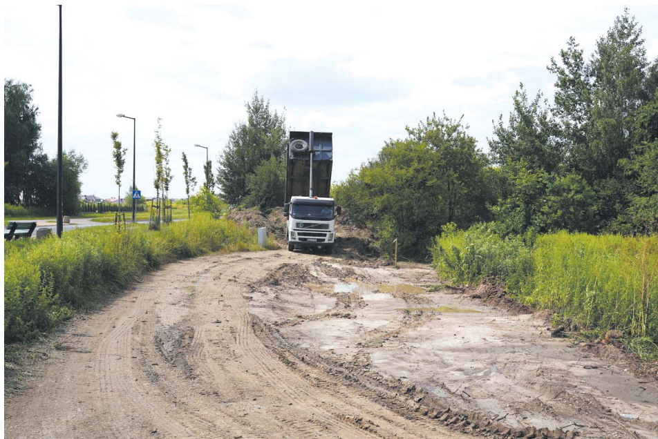
Prace przy nowej drodze w Łęcznej ruszyły w minionym tygodniu
