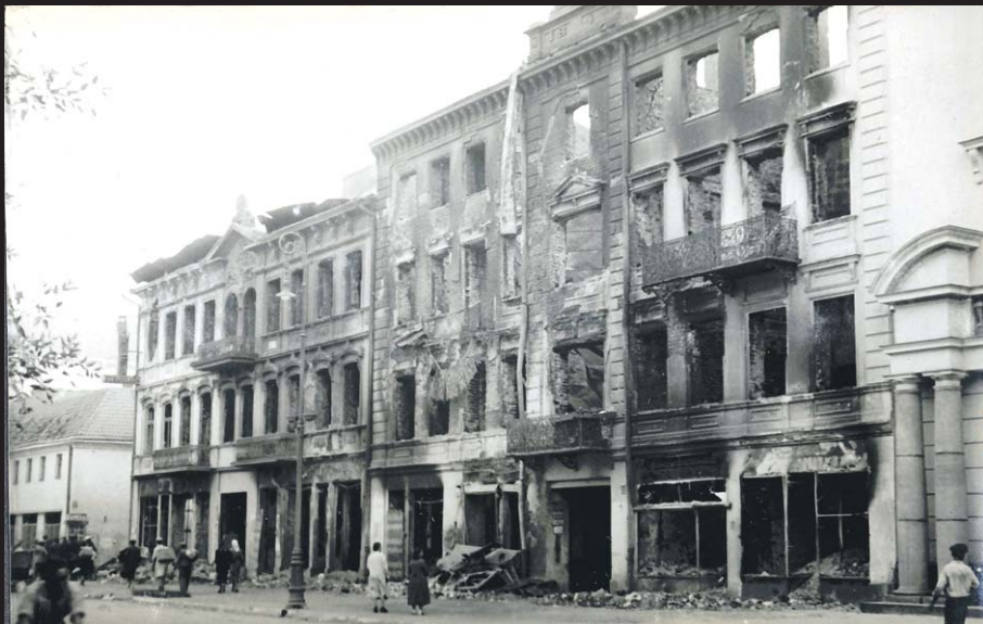
Zniszczone w trakcie bombardowania Lublina 9 września 1939 r. kamienice przy Krakowskim Przedmieściu nr 46 i 48. Zdjęcie Ludwika Hartwiga z albumu Zniszczenia w Lublinie na skutek bombardowania przez Niemców w dn. 9.IX.1939 r. (ZBIORY APL)
