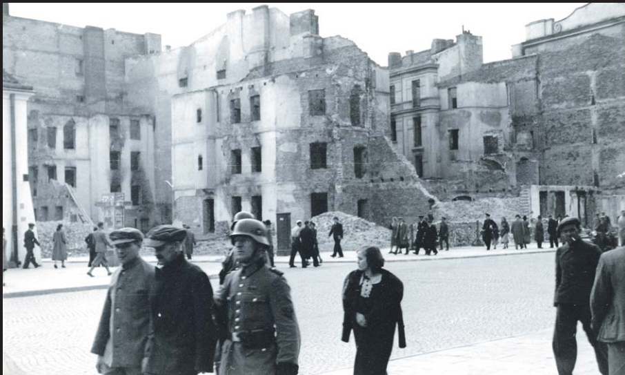
W tym miejscu znajdowały się kamienice nr 46 i 48 przy ulicy Krakowskie Przedmieście. Fotografia zrobiona po 1940 r. (AUTOR NIEZNANY, ZBIORY MARKA GROMASZKA)
