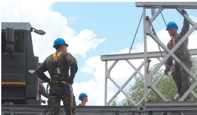
Saperzy stawiają most w miejscu wyrwy w Kuzawce nad Bugiem
