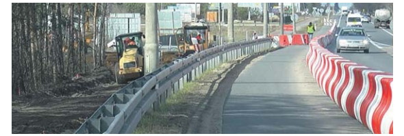
Brakujący fragment ścieżki rowerowej w budowie
