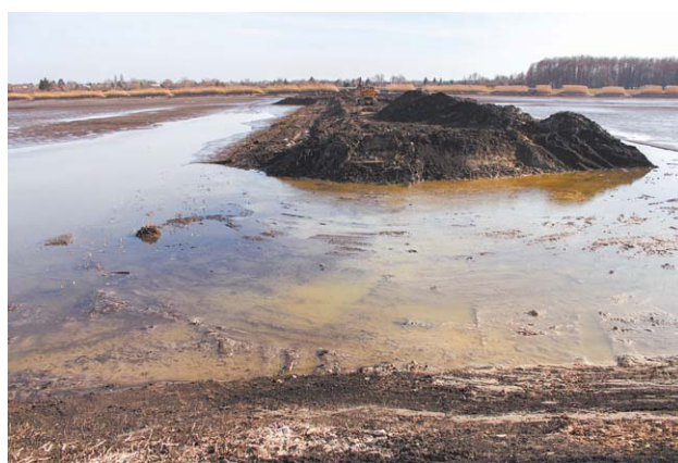
Budowa wyspy na Zalewie Miejskim
