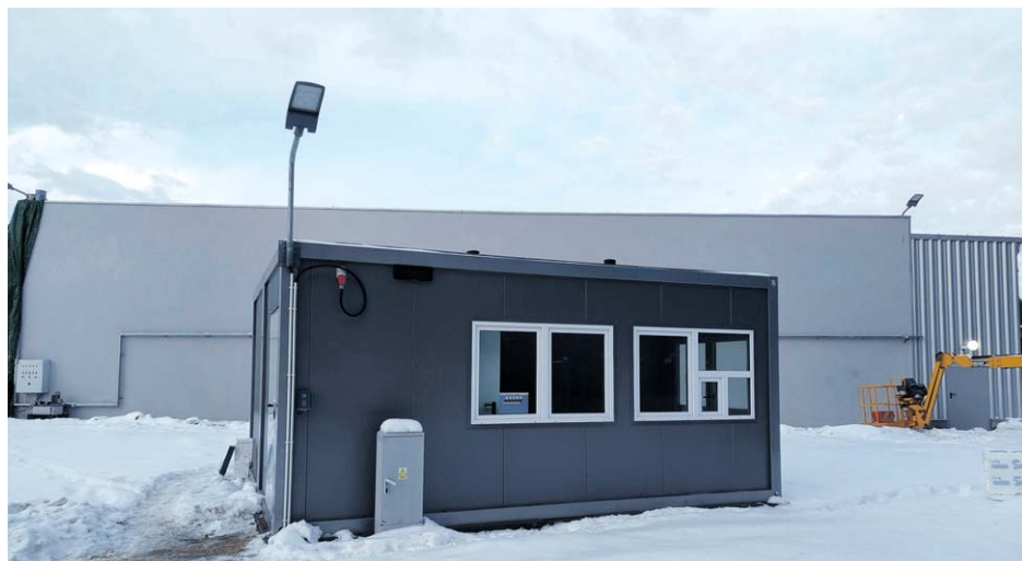
Fot. 4 Widok na kontener biurowy i bioreaktory na kompostowni osadów ściekowych
