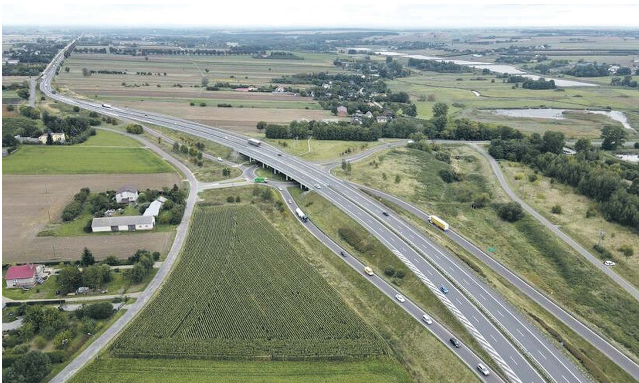
Węzeł Piaszki Wschód, na którym połączą się drogi S12 i S17
