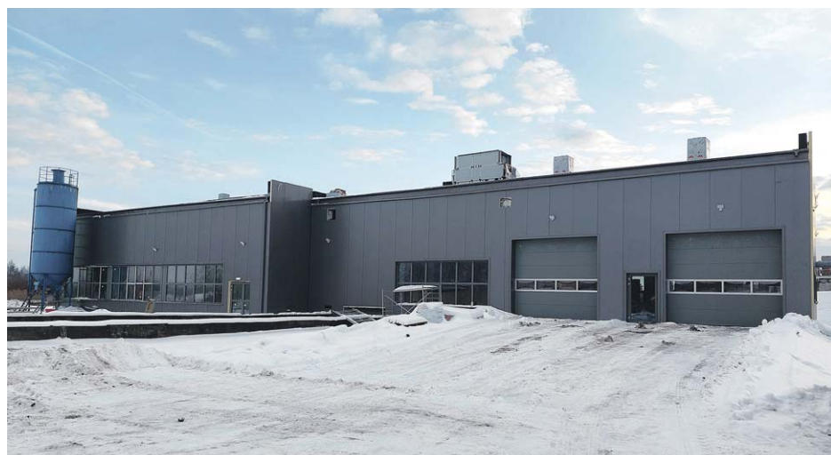
Fot.1 Widok na elewację budynku krat i odwadniania osadu na terenie oczyszczalni ścieków w Łukowie
