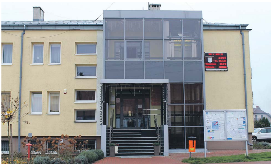
Jedną z przyszłorocznych inwestycji ma być warty ok. 450 tys. zł remont dachu na siedzibie Urzędu Gminy
