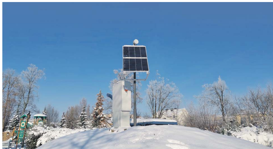
Fot. 3 Widok na zmodernizowane ujęcie wody w Parku miejskim
