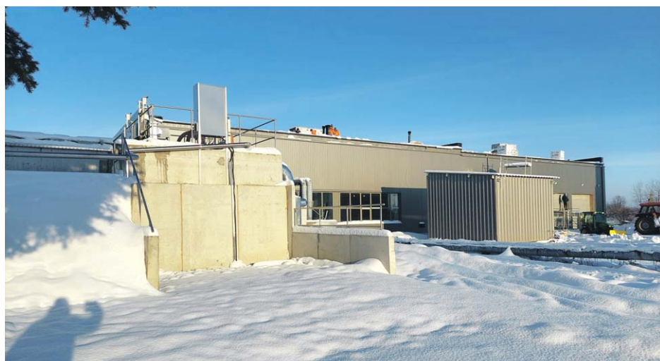
Fot.2 Widok na piaskownik i przepompownię główną na terenie oczyszczalni ścieków w Łukowie
