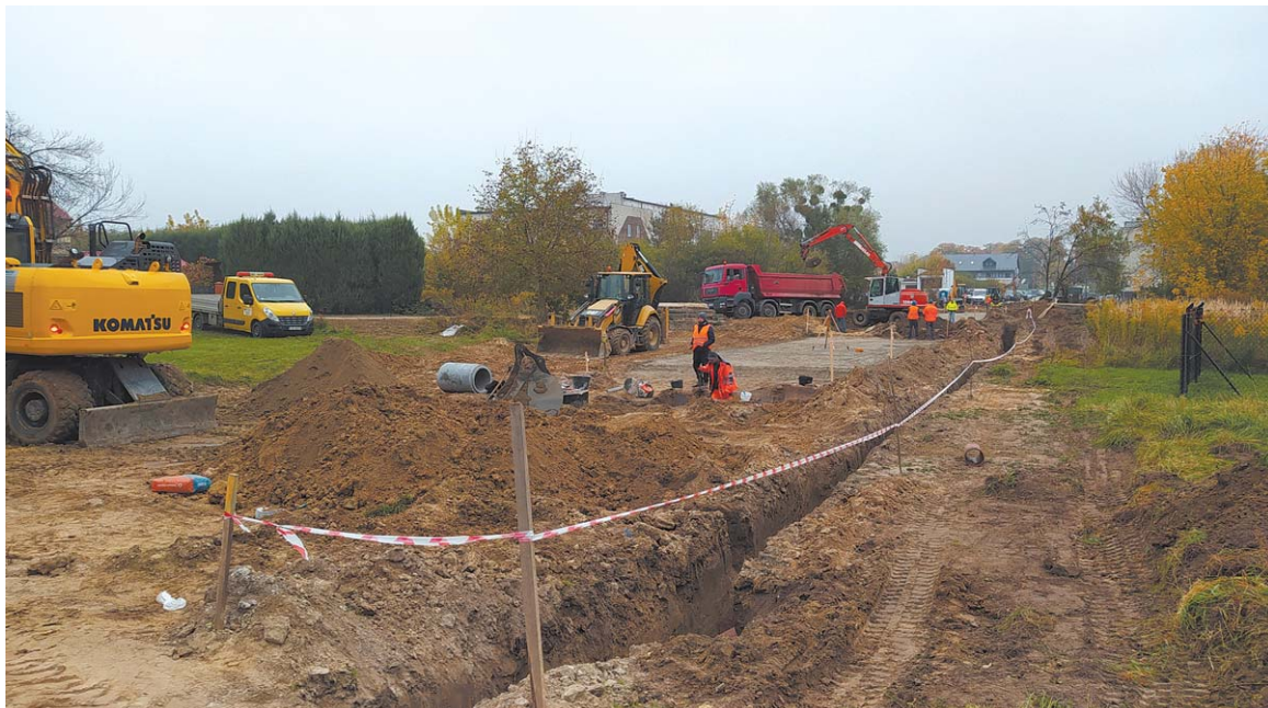
Trwa już budowa kanalizacji deszczowej oraz usuwanie kolizji z siecią wodociagową i sanitarną. Rozpoczęła się też budowa linii zasilających oświetlenie uliczne, a także roboty konstrukcyjne. FOT. UM ŁĘCZNA
