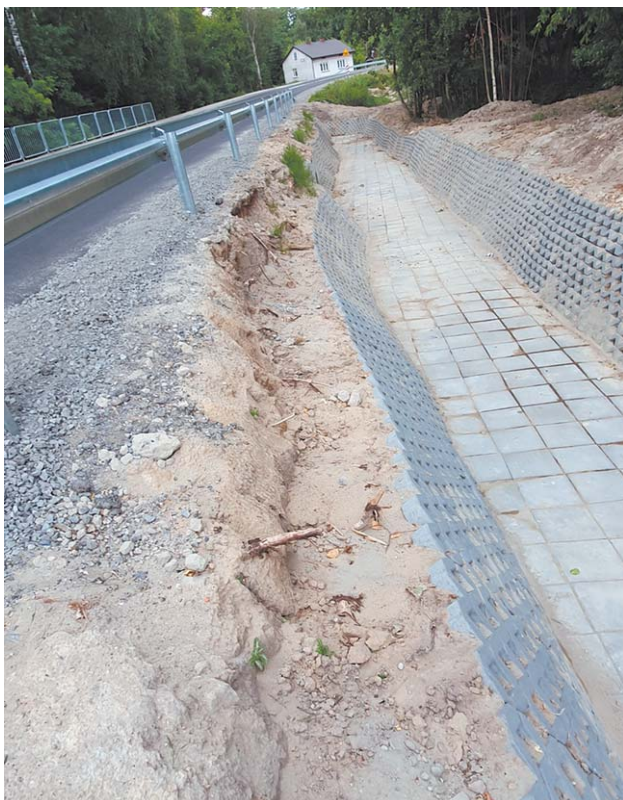
Tak wygląda po przebudowie fragment drogi w Krężnicy Jarej
