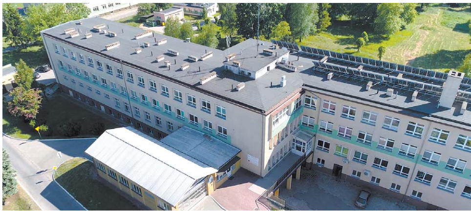
FOT. SZPITAL W PARCZEWIE
