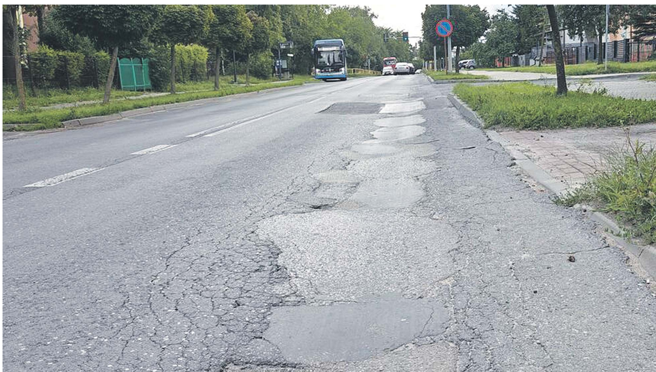
W Chełmie w tym roku rozpocznie się długo oczekiwana modernizacja ulic Fabrycznej i Przemysłowej
