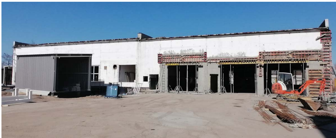
Fot. 1 Pompownia główna i bud. odwadniania osadu na terenie oczyszczalni ścieków w Łukowie
