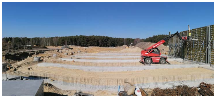
Fot. 3 Roboty fundamentowe pod bioreaktory, płuczkę i biofiltr kompostowni osadów ściekowych
