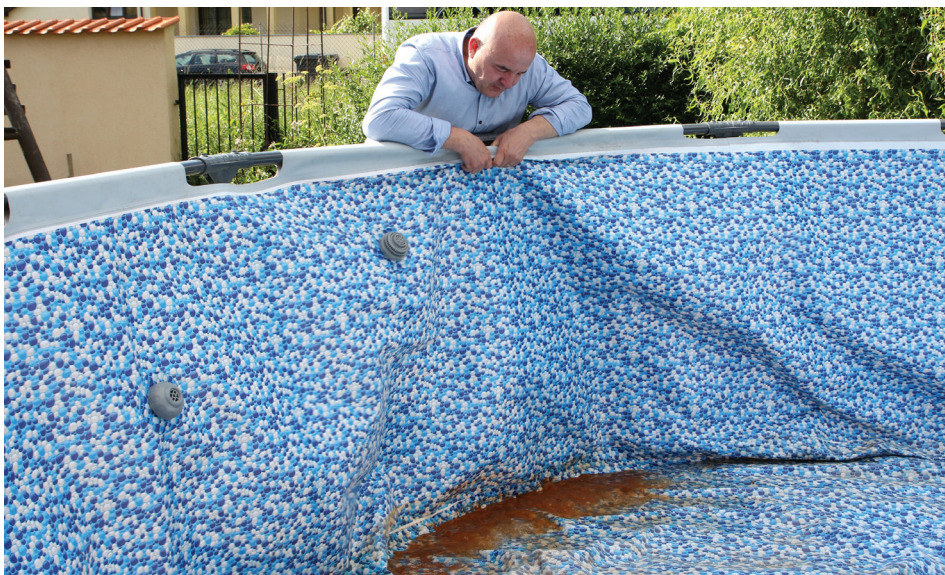
Marek Pawulski z trudem doczyścił basen po rdzawym osadzie, którym zaległ na jego całym dnie tuż po napełnieniu zbiornika wodą z miejskiego wodociągu
