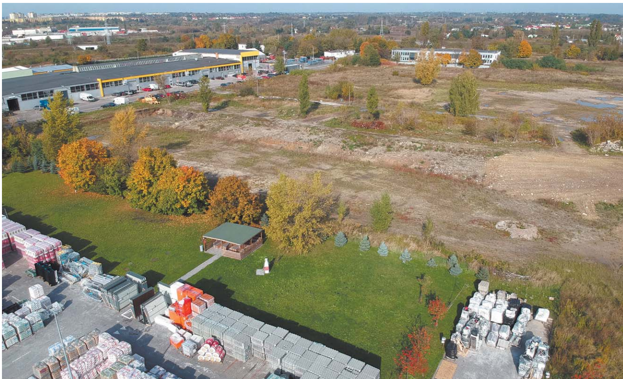
Ul. Mełgiewska. Przyczyną usunięcia drzew i krzewów jest budowa hal magazynowych. Aktualnie wniosek jest weryfikowany, decyzja nie została jeszcze wydana
