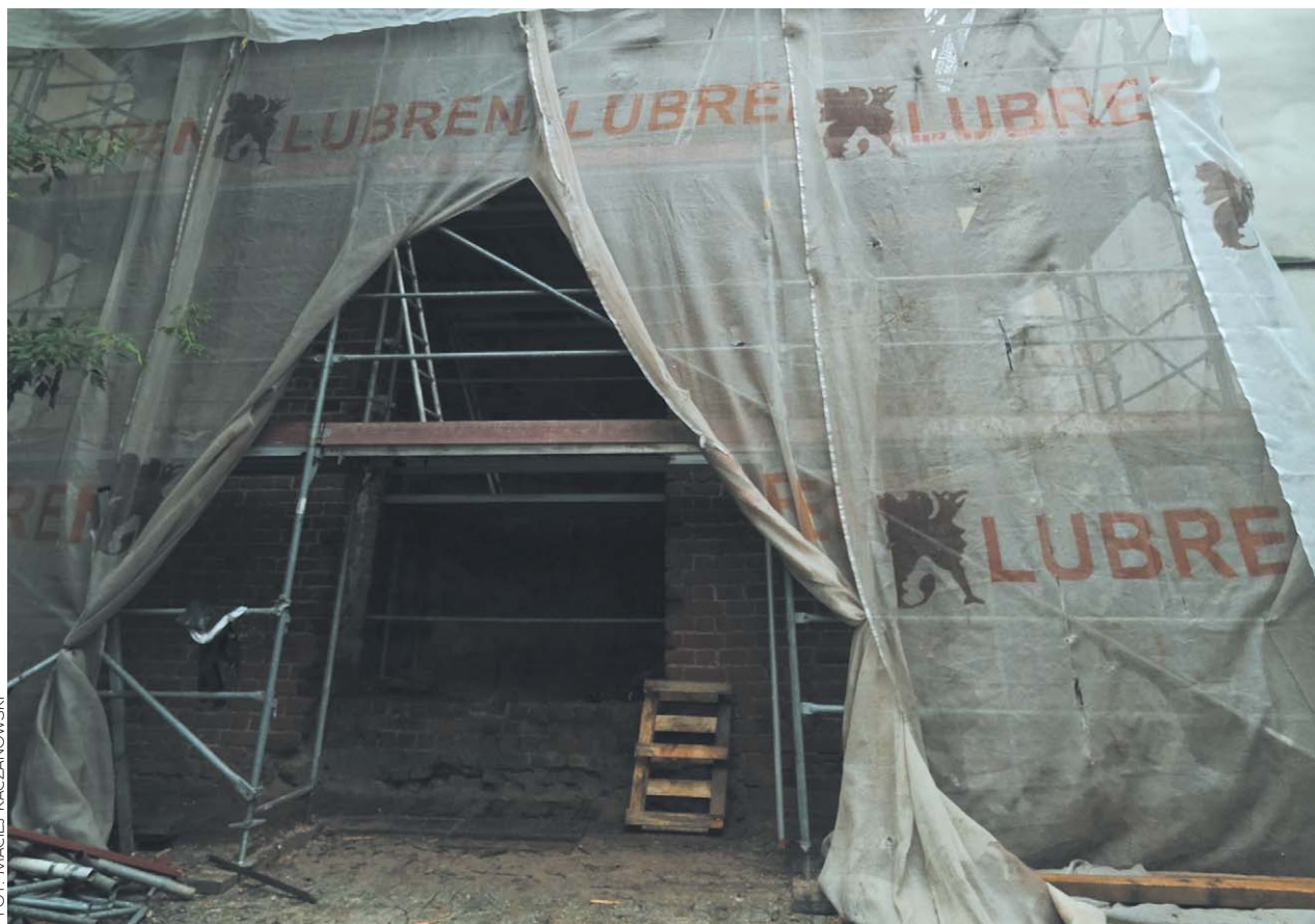
Gzys baszty ma być otynkowany, projekt przewiduje również rekonstrukcję kamiennych detali
