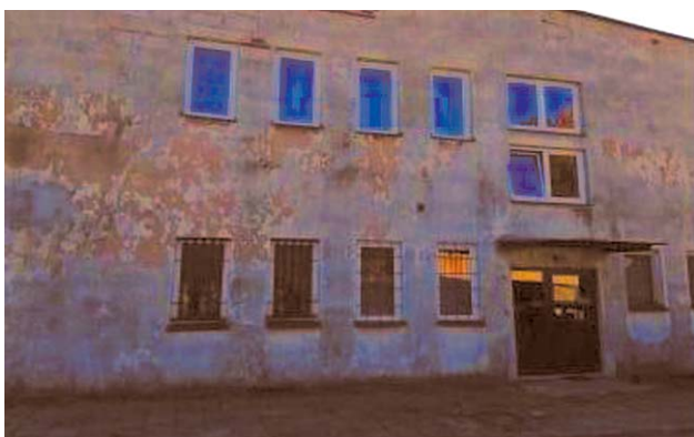
Dwa lata temu budynek ZGKiM przeszedł termomodernizację
