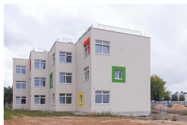
W budynku trwają prace wykończeniowe
