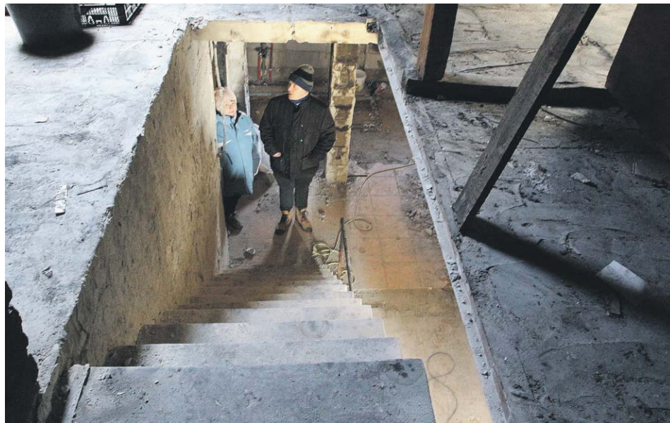
W domu państwa Furtaków i Grykałowskich nadal czuć charakterystyczny swąd. Na parterze trwa walka z wilgocią. Większość pomieszczeń zaczyna przypominać stan surowy. Odbudowa będzie długotrwała i kosztowna
