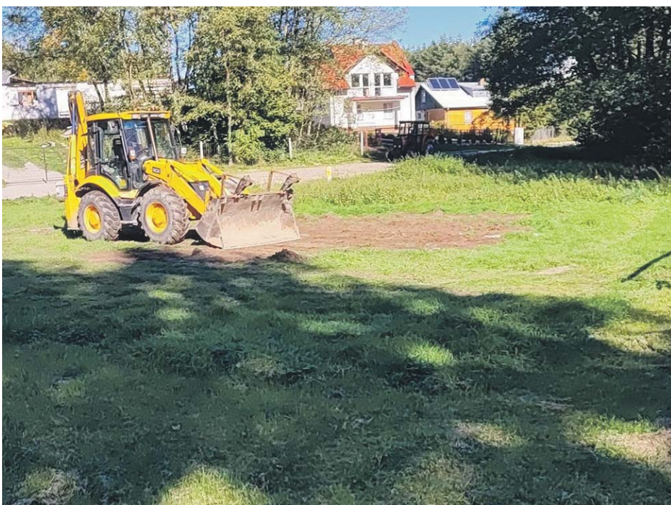
Miejsce do gry w piłkę nie będzie zastawione altaną. Wczoraj już wyrównywano doły, które powstały z myślą o inwestycji
